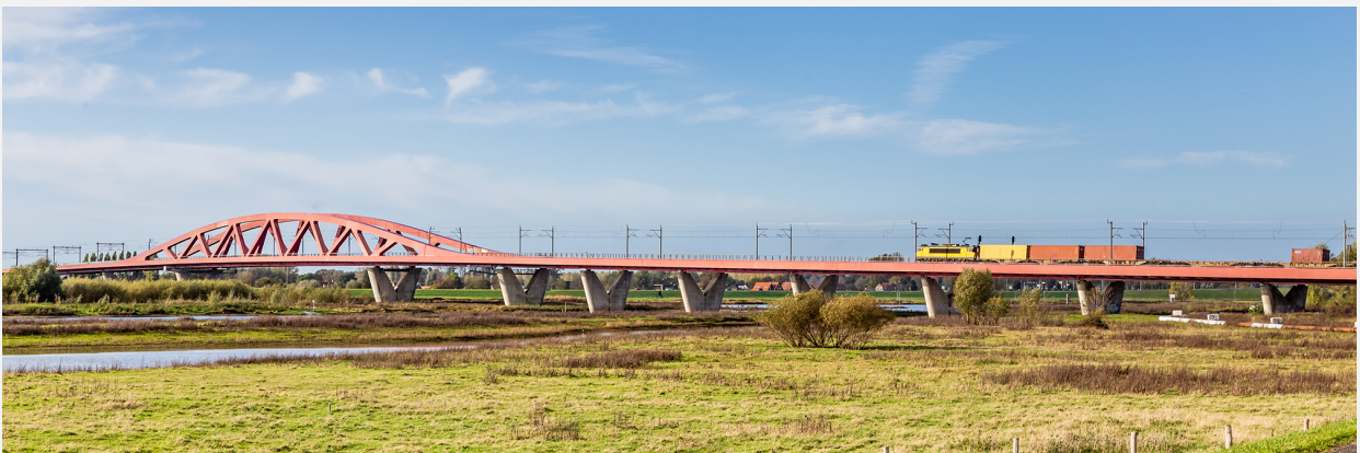
Project IJsselspoorbrug bij Zwolle.
